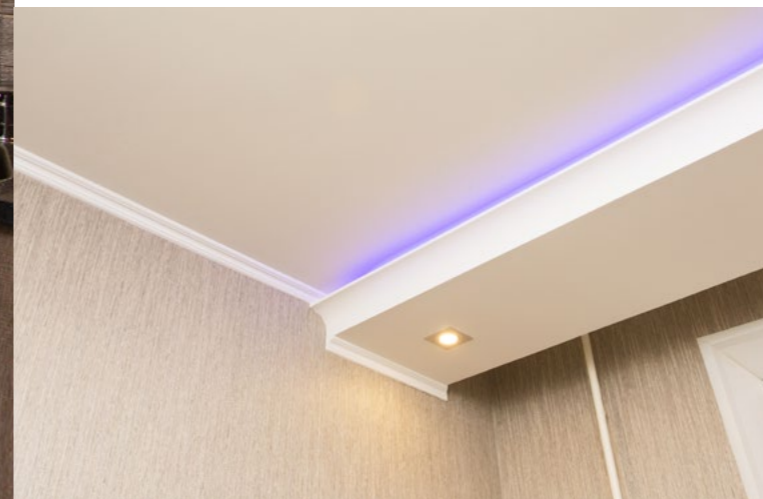
Потолочная конструкция со светодиодной подсветкой
