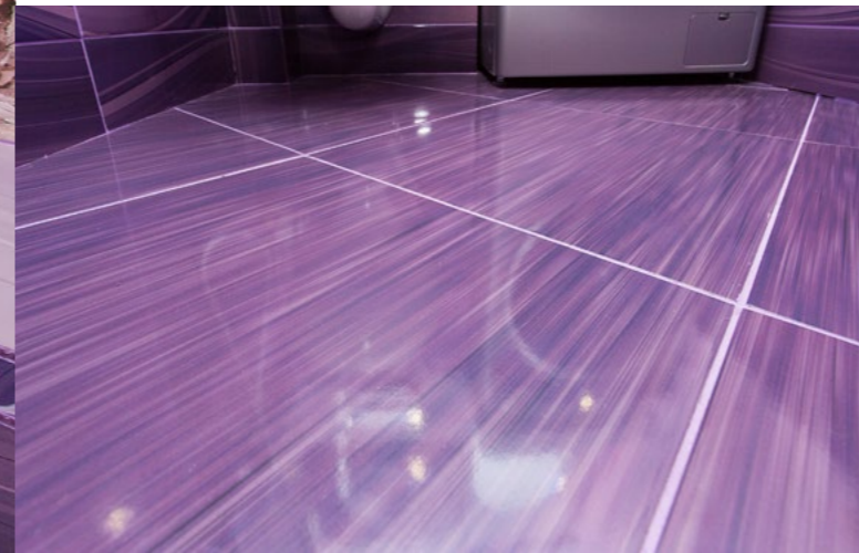
Плитка на полу уложена по диагонали
