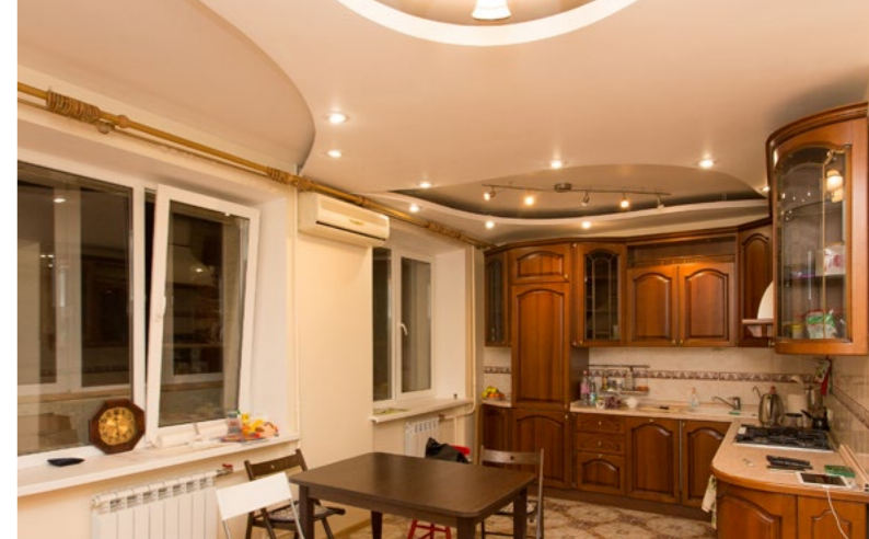
Конструкции из гипсокартона нестандартных форм
