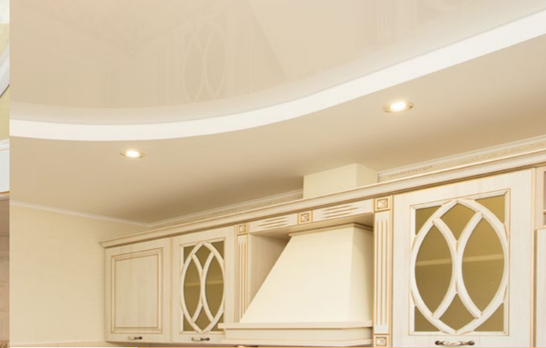
Потолок из гипсокартона со встроенными светильниками
